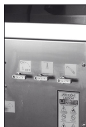
03. Válvulas ON/OFF pulverización o brocha (2 uds.)
