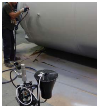
Serbatoio a gravità
